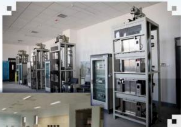
智能电梯安装调试维护训练场所
